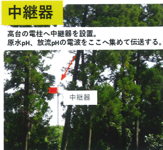
写真5.2.5.1 中継器設置場所
